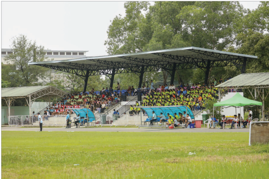
၂၀၂၄ ခုနှစ်အတွင်း ဘောလုံးအဖွဲ့ချုပ်ပိုင် လေ့ကျင့်ရေးကွင်း (၁) အား ပရိသတ်ပွဲကြည့်စင် တည်ဆောက်ခြင်း။
